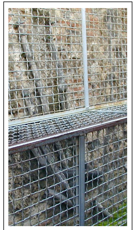
水道管の分岐
